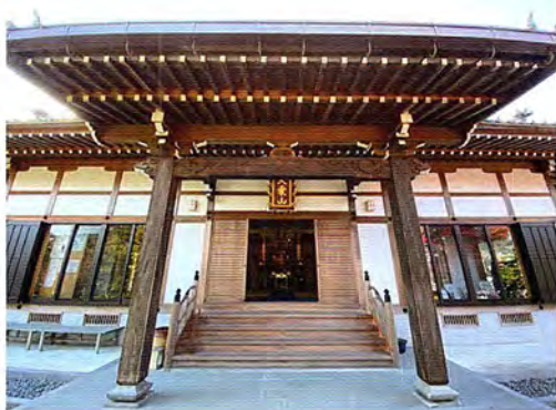
平成22年に落慶した教伝寺本堂の正面。すぐ目の前の崖下に国道9号線が走っている
