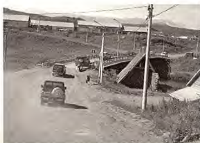
択捉島。道路の舗装が進んでおらず、 砂埃を上げて車が走る
