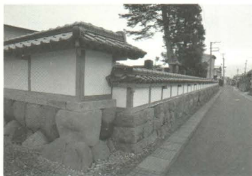
平成二十二年に落慶したのは本堂の屋根、山門の屋根の葺き替え、そして仰徳殿と東塀の改修工事だが、塀も見事な石積みの塀になった
