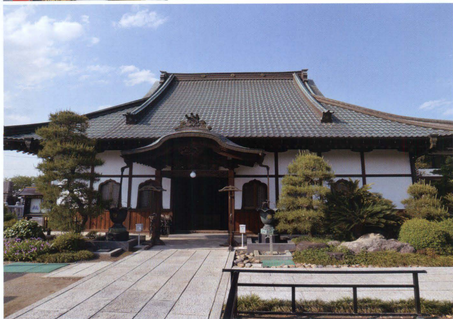
寛永九年（一六三二）創建の西福寺、本堂を支えているのは当時からの柱だという。
