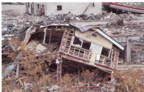
アメのように曲がった鉄骨。かつては密集した住宅街だった荒町地区が。
