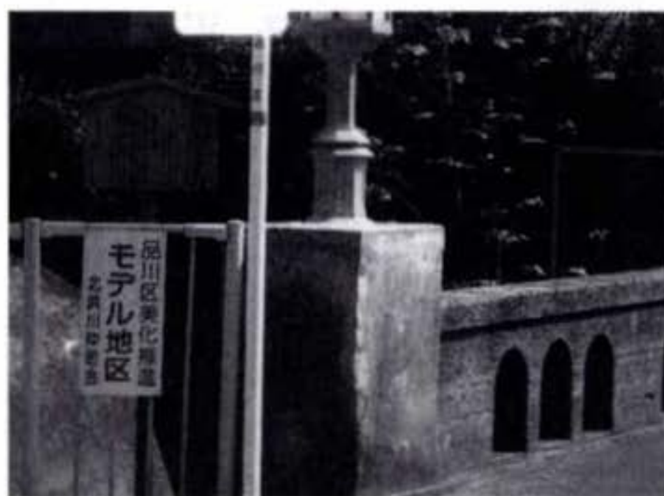
◆立会川「浜川橋」
