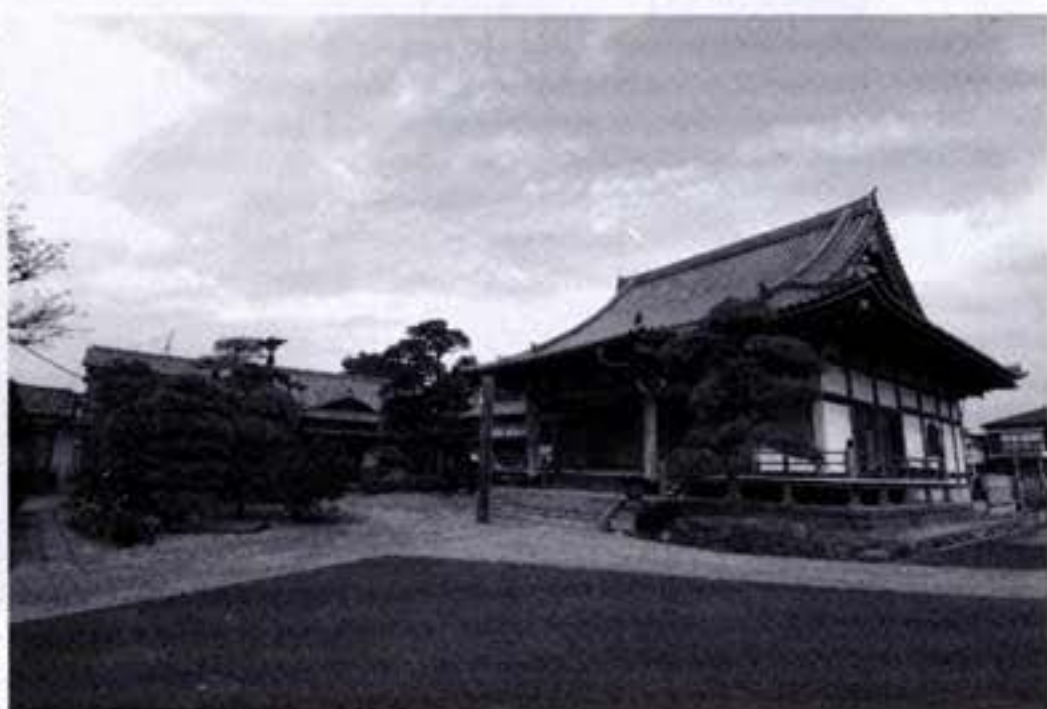
金蔵寺本堂は平成七年、前住職時代に建立された。昭和十二年に建てられた間口四間半、奥行五間本堂は七間四面の伽藍に生まれ変わった
