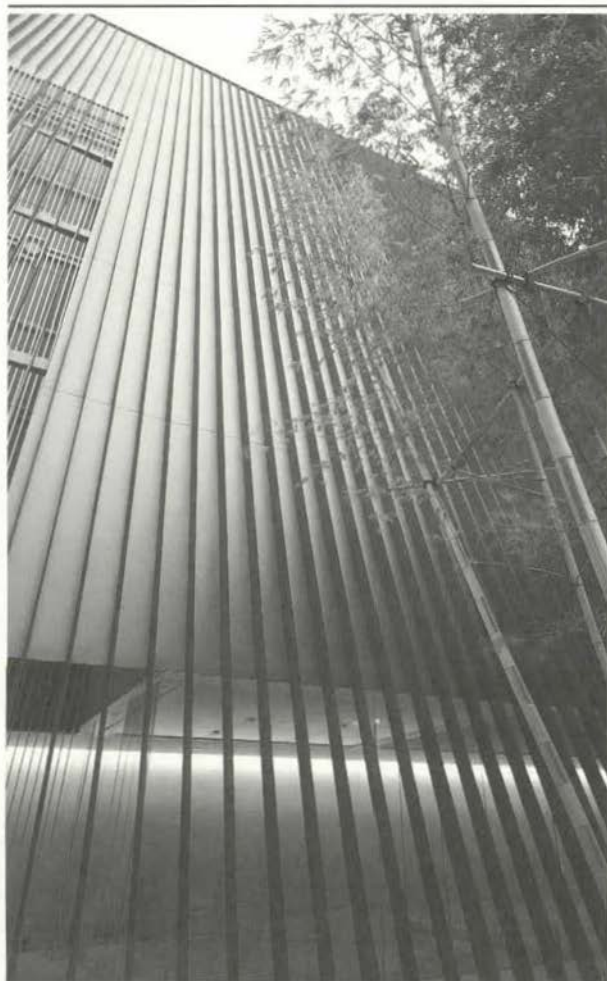
隈氏にとって寺院建築の第一号となった東京・青山の梅窓院
