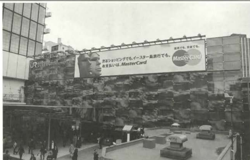
渋谷駅南口の壁面に雲を浮かべた
