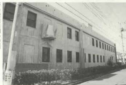
新会館道路側の壁面
