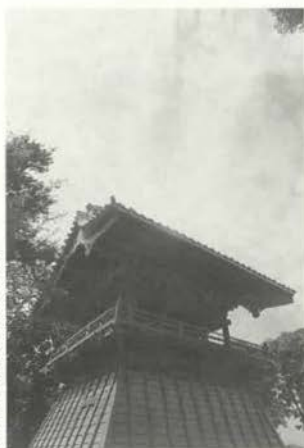
本堂斜め前の報国寺鐘楼
