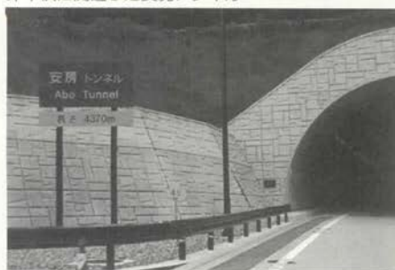
昨年秋に開通した安房トンネル
