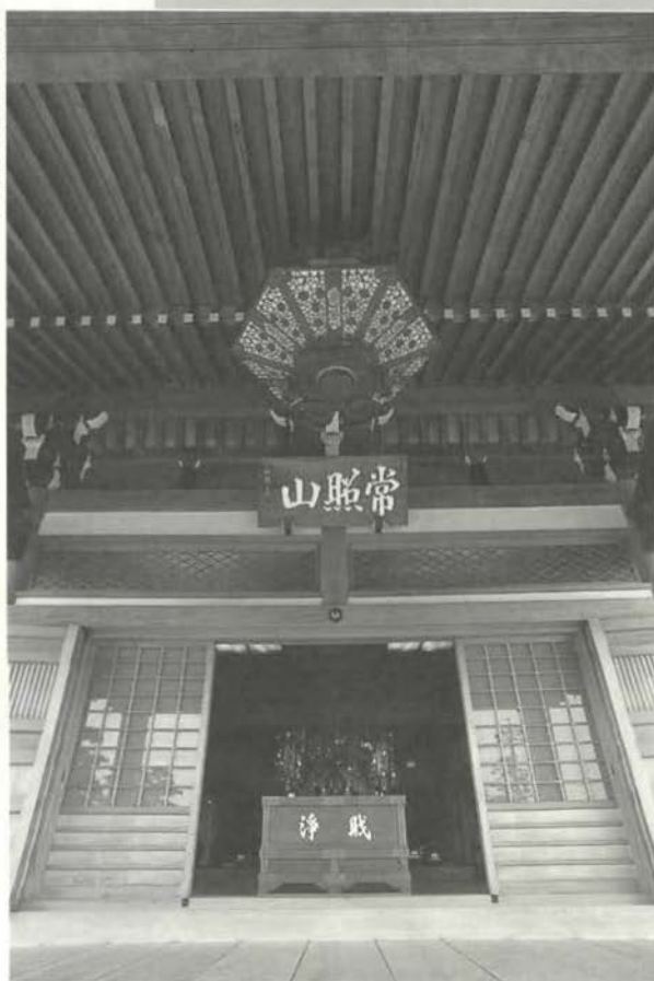
常照山光心寺本堂正面
