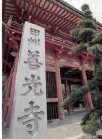
金堂とともに重要文化財の山門
