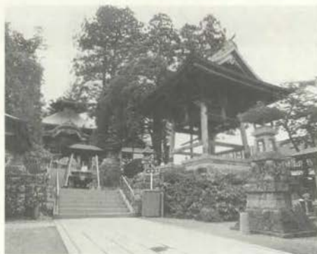
山門を入ると立派な鐘樓がそびえる。
