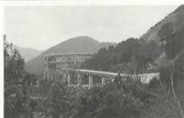
国道414号の七滝ループ橋
